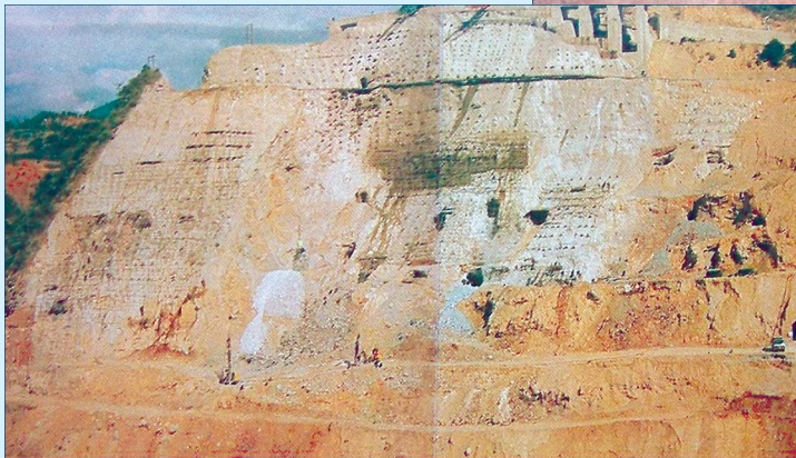
滑坡发生后的左岸地貌
