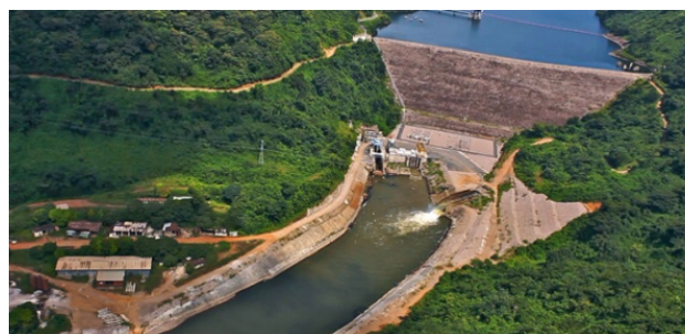
塞拉利昂本布纳水电站二期工程
