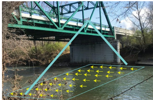
使用搭载在无人机上的探地雷达系统（图中白色设备）测绘河流水深。
