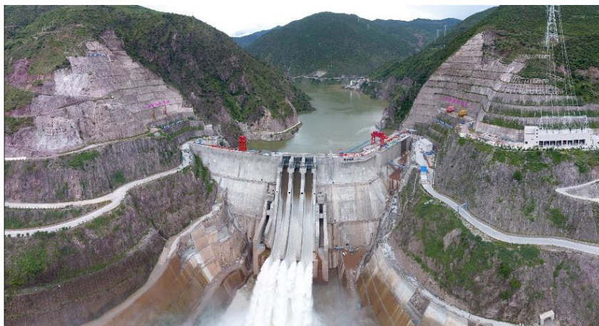
我国最高 RCC 重力坝—黄登（实现无缝大坝建设目标）
