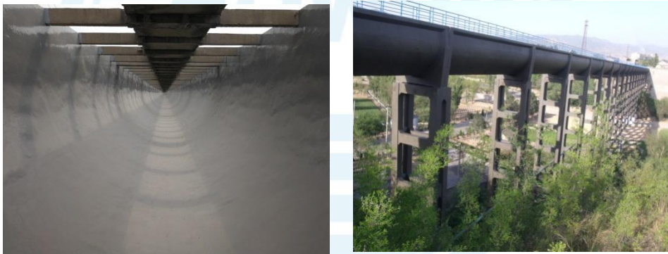
渡槽内外修复处理效果
