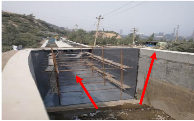
设计思路：渠道加高处理+渡槽涂层降糙增流
