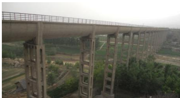
禹门口灌区 11#渡槽原貌
