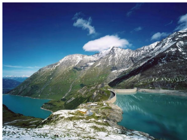
奥地利典型的抽水蓄能项目
