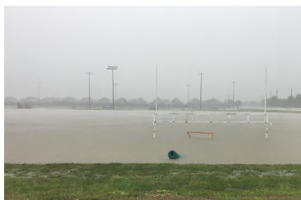
图 5. 2017 年在飓风哈维发生期间，德克萨斯州弗朗兹伍德一所初中的运动场使用的滞洪池。
