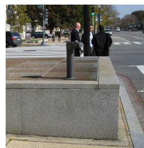
图 7. 华盛顿地铁地下通道的永久性保护设施。
