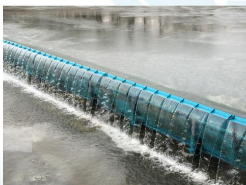
图 1 合页活动坝坝面过水
