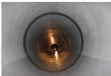
图 3 PCCP 补强加固后照片
