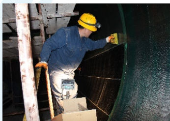
图 2 CFRP 补强加固施工
