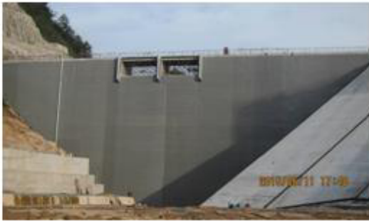
洪屏电站混凝土坝上游面防渗
