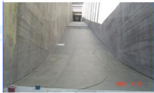
李家峡水电站泄洪道抗冲磨防护
