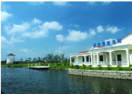
图1 南方示范泵站管理房
