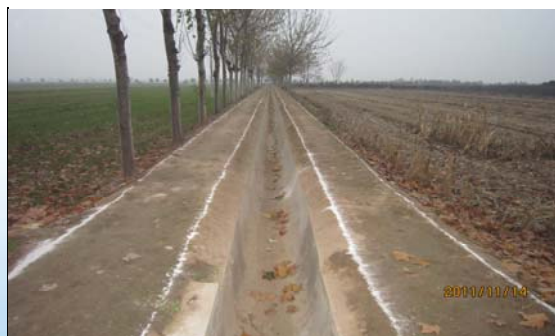
图4 渠灌区示范工程
